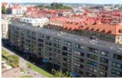
NORDOSTPASSAGEN - Göteborg Holger Blomstrand Byggnads AB Ombyggnad av 158 lägenheter. 2016-17.
