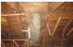
KV. KNAPPNÅLEN - Göteborg Holger Blomstrand Byggnads AB Ombyggnad av råvind till 26 vind- slägenheter. Inflyttning 2017.
