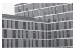
CHABO Chalmersfastigheter AB Studentbostäder i Göteborg. Nyproduktion av 479 lgh. Systemhandling 2005. Handläggande ark. Wingårdhs Färdigställt 2006.
